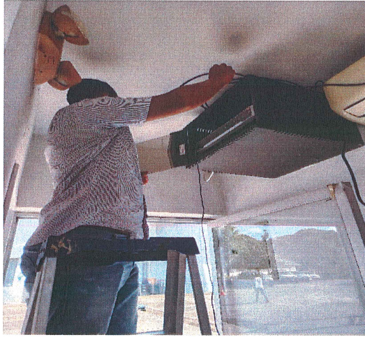
Figura 2. Conexión del cable de red UTP al NVR Institucional
