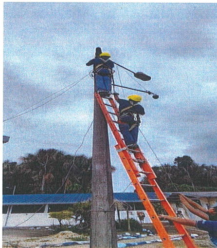
Figura 12. Instalación de la cámara PTZ
