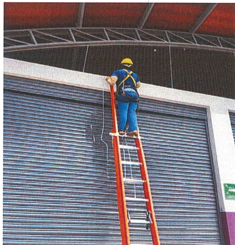
Figura 8. Instalación del cable UTP
