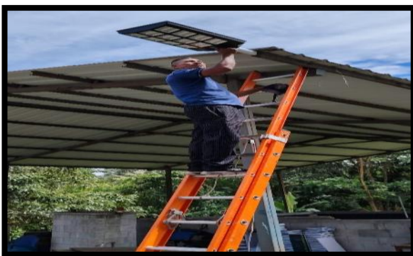
Colocacion e instalacion de la lampara led en la zona de vulnerabilidad
