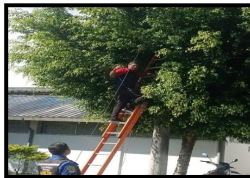
Tendido del cableado por el poste eléctrico
