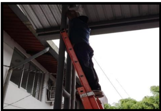
Tendido del cableado en la cubierta de la institución
