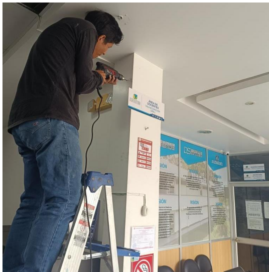
Figura 25 Reubicación de Cámara Tipo domo en el área de docentes Bloque 2.
