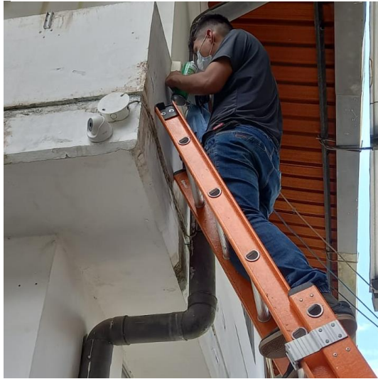
Figura 24 Fase de mantenimiento
