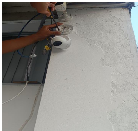
Figura 26 Reubicación de Cámara Tipo domo en el Bloque 1.
