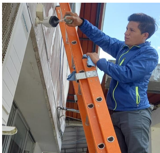
Figura 22 Fase de mantenimiento.
