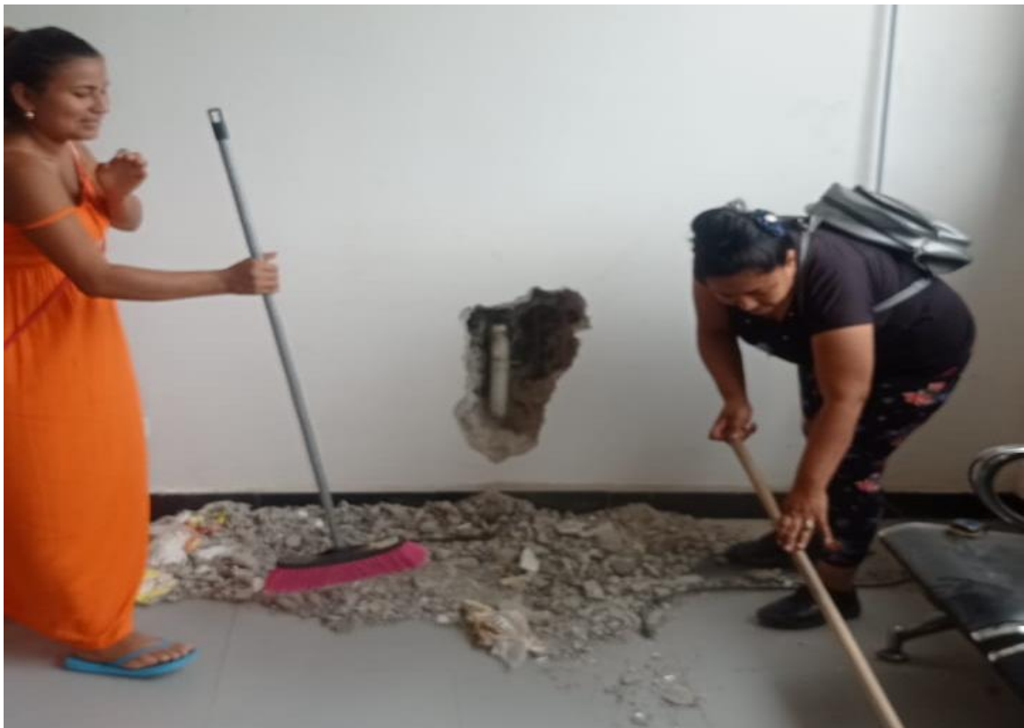
Limpieza y adecuación del espacio para ubicar los equipos de diagnóstico
