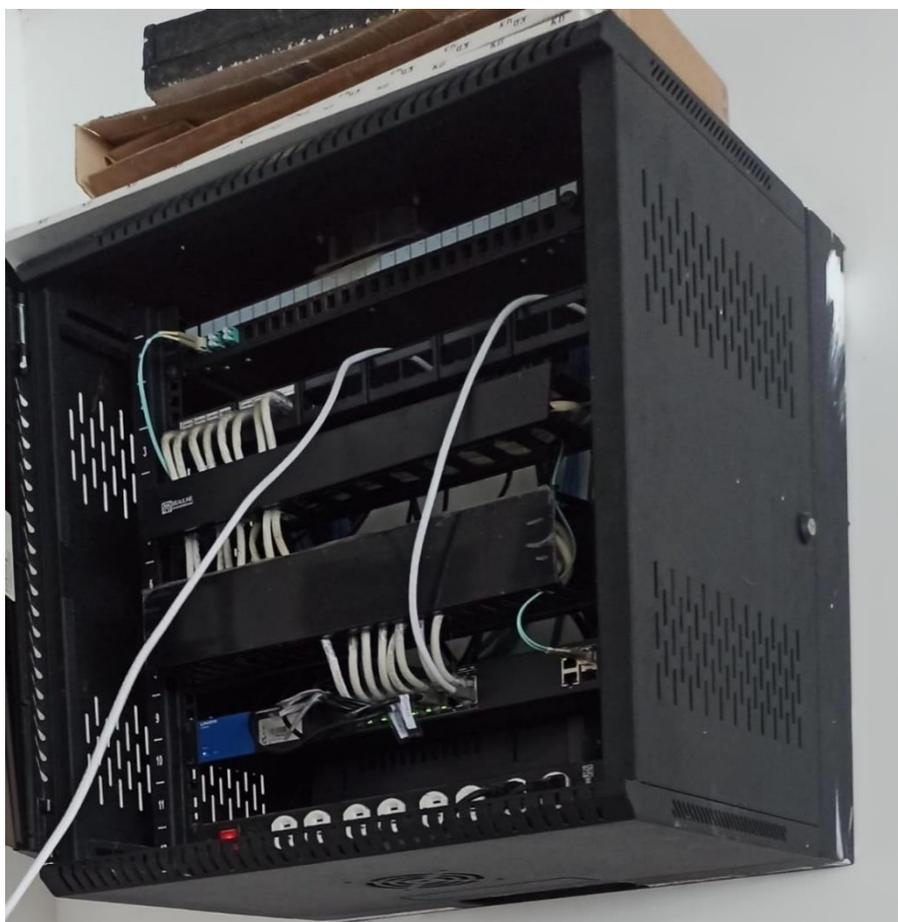
*Nota:* La figura muestra el rack que se encuentra a lado del área de comunicación, con el fin de verificar sus puertos.
