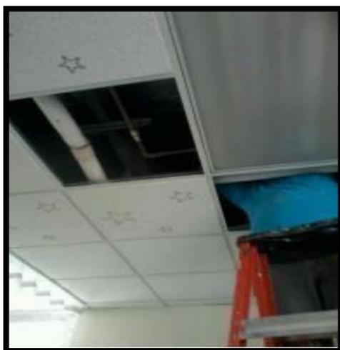
**Figura N ° 3:** Colocación de cable UTP interno
