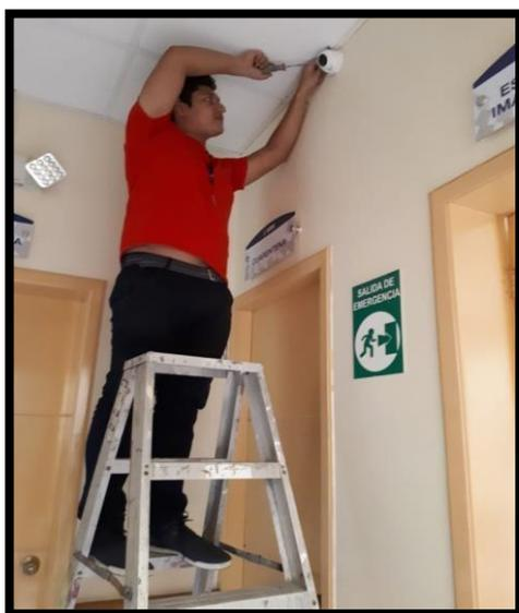
**Figura N ° 4:** Ajuste óptimo de cámara
