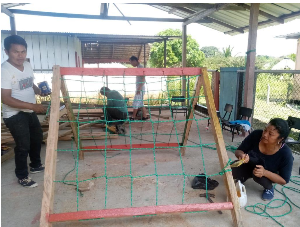
Construcción de los juegos infantiles (araña)
