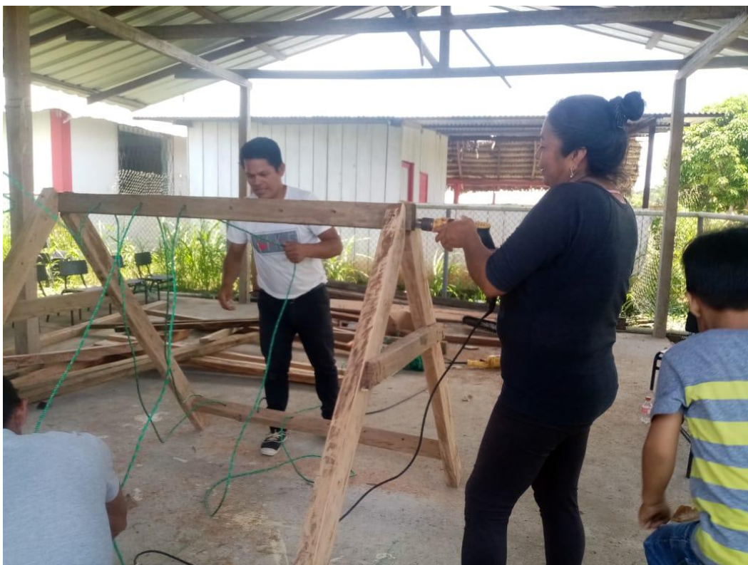
Construcción de los juegos infantiles (araña)
